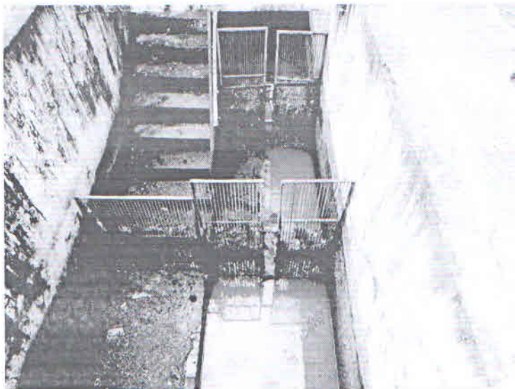
Foto 7.1 – Gradeamento EEE Britador.
